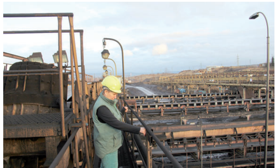
Výsuvové hlavy jsou v lokalitě Vršany na místě, kde se sbíhají linky pásových dopravníků. Foto: (pim)
