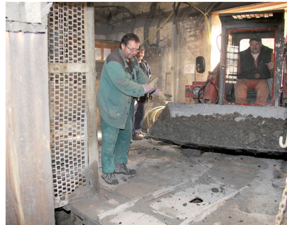
Kromě speciálního zásypového materiálu se na likvidaci těžních jam používá také šterk. Foto: (pim)
