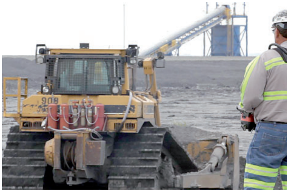
Dálkovým ovládáním se dají osadit i patnáct let staré dozery. Foto: RCT
