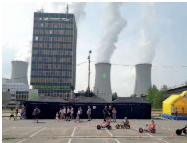
Doprovodný program pro děti byl připraven už před branami elektrárny.
