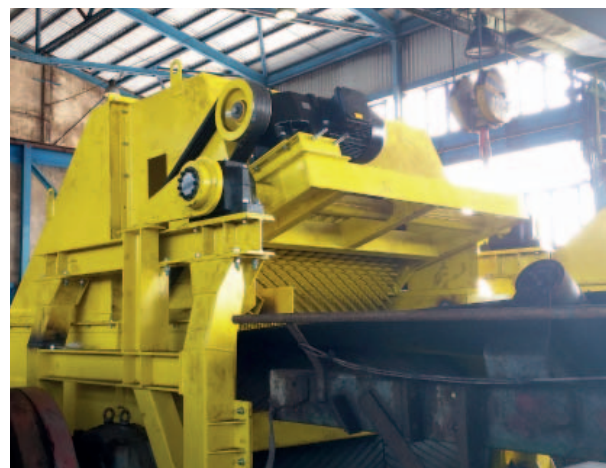
Během odstávky úpravně byl na dopravníku P22 v lokalitě HMGD instalován už druhý rozvolňovač. Foto: (lipo)
