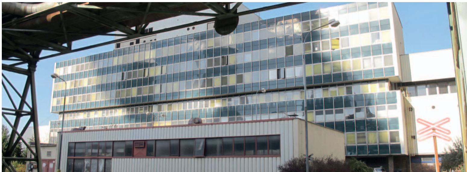
Pohled známý návštěvníkům chvaletické elektrárny ještě z nedávné doby, než se začalo s opravami.
