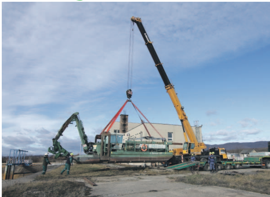
Stroj se musí zvednout jeřábem a posadit na speciální návěs určený k přepravě těžké techniky.
