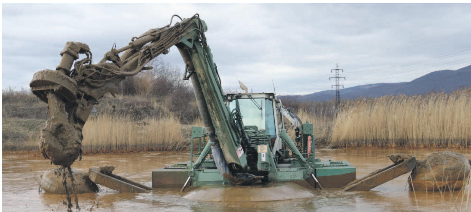
S čištěním usazovací jímky úpravy důlních vod už si poradí většinou bez větších potíží. Foto: 4x (pim)
