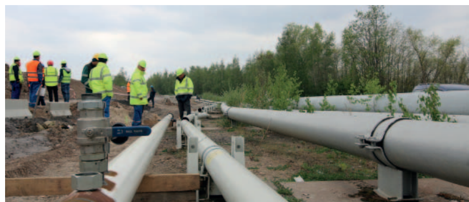
Takto to na staveništi vypadalo letos v dubnu. Foto: Archiv DN
