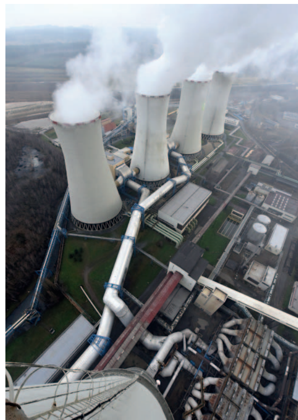
Pohled z komína na chvaletickou elektrárnu. Foto: 4x Archiv 7EC
