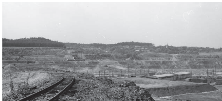
Lom a hornická čtvrť během výstavby elektrárny. Foto: 4x archiv 7EC
