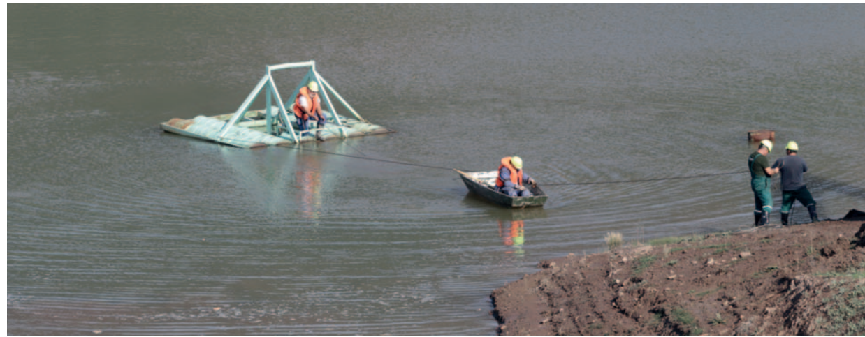
Jedno z největších plovoucích čerpadel muselo po šesti letech provozu ven z vody. Foto: (pim)
