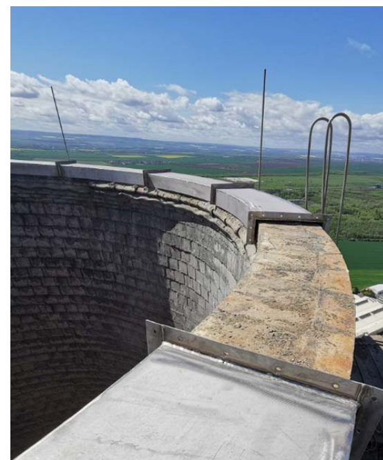
Oprav se dočkaly také elektrárnské komíny. Foto: archiv EPOČ
