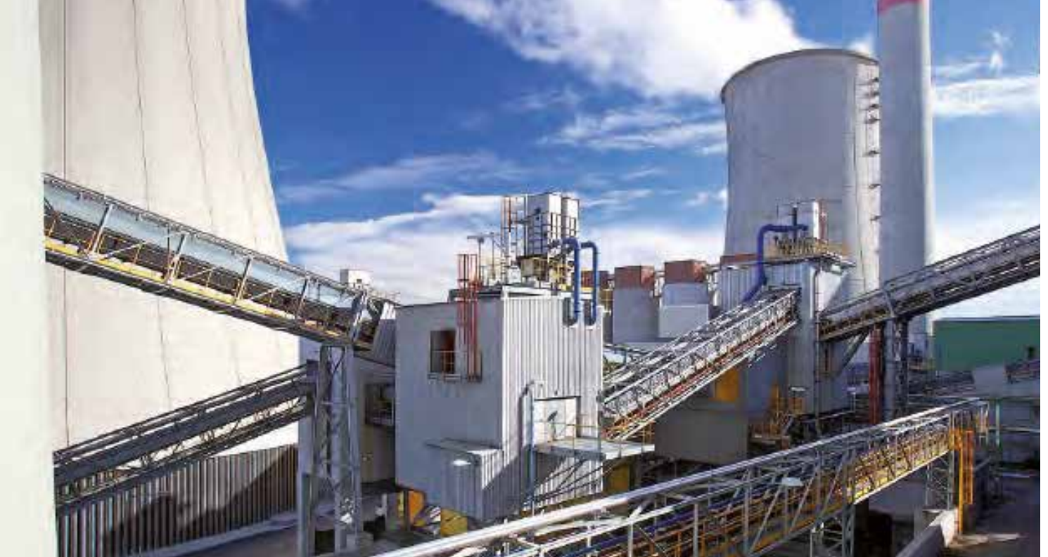
▲ Pohled na zauhlovací trasy nového bloku K7
